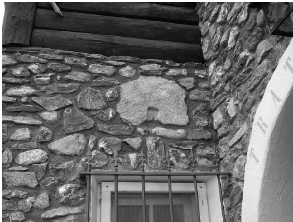
Fig. 23) Macina inglobata nella muratura del Ristorante di Fenils. Si noti che qui l'impronta della nottola è quella tradizionale, tipica di quando questo sistema usava due ali e non tre.
