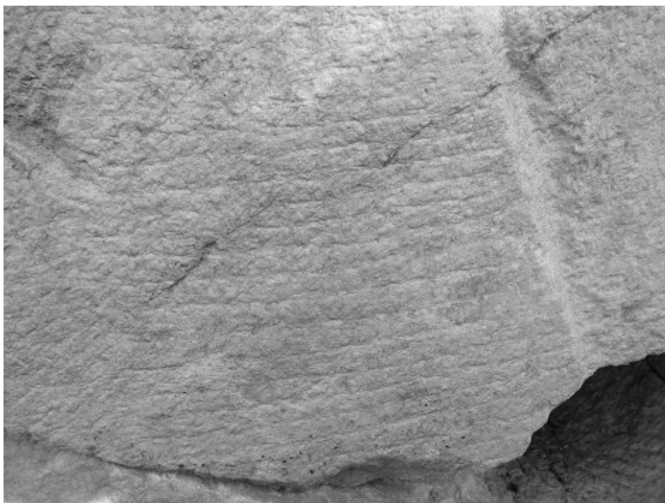
Fig. 21) Dettaglio: si notino le rugosità create con la rabbigliatura.
