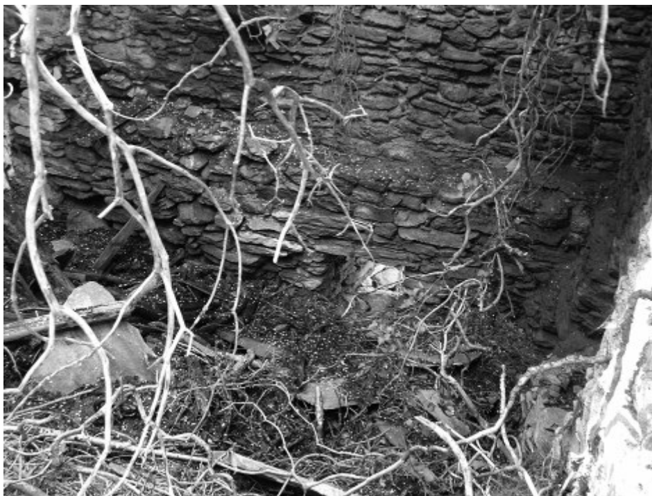
Fig. 25) Mulini del paese, a Chiomonte. All'interno, dotato di più piani, si può vedere la fuga delle acque e la risega che sosteneva il soppalco.
