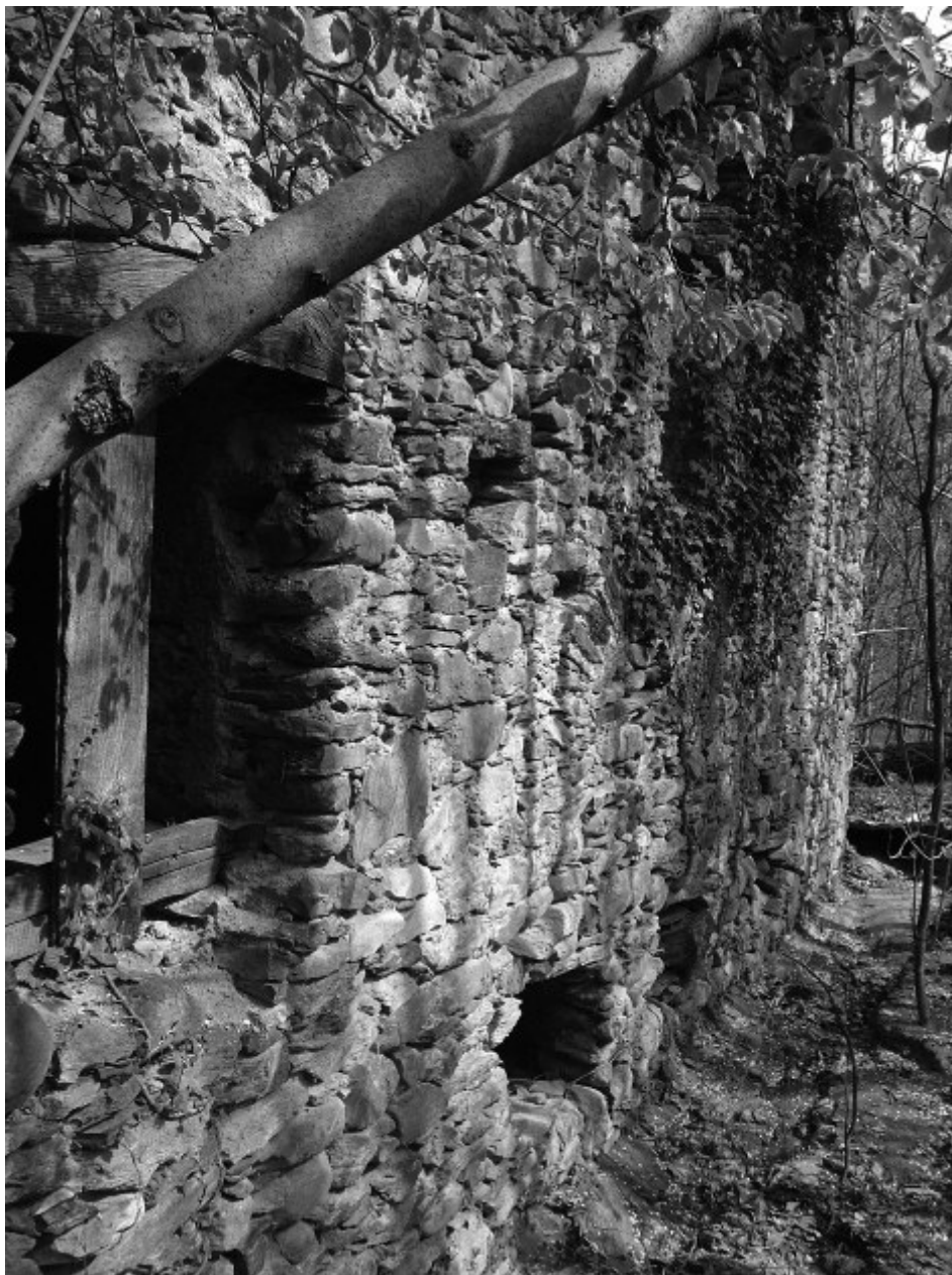
Fig. 36) Ingresso delle acque del grande mulino a tripla ruota orizzontale.
