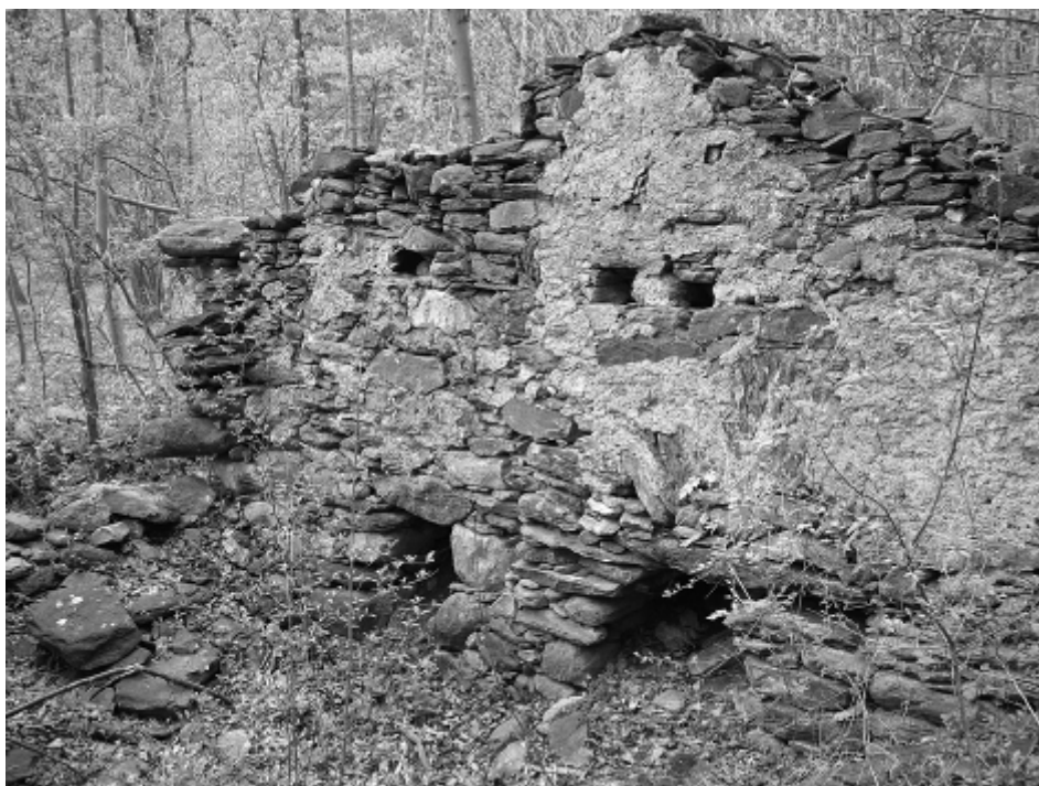
Fig. 38) Rudere di uno dei due mulini a ruota orizzontale, a monte della borgata: si noti il doppio ingresso delle acque.
