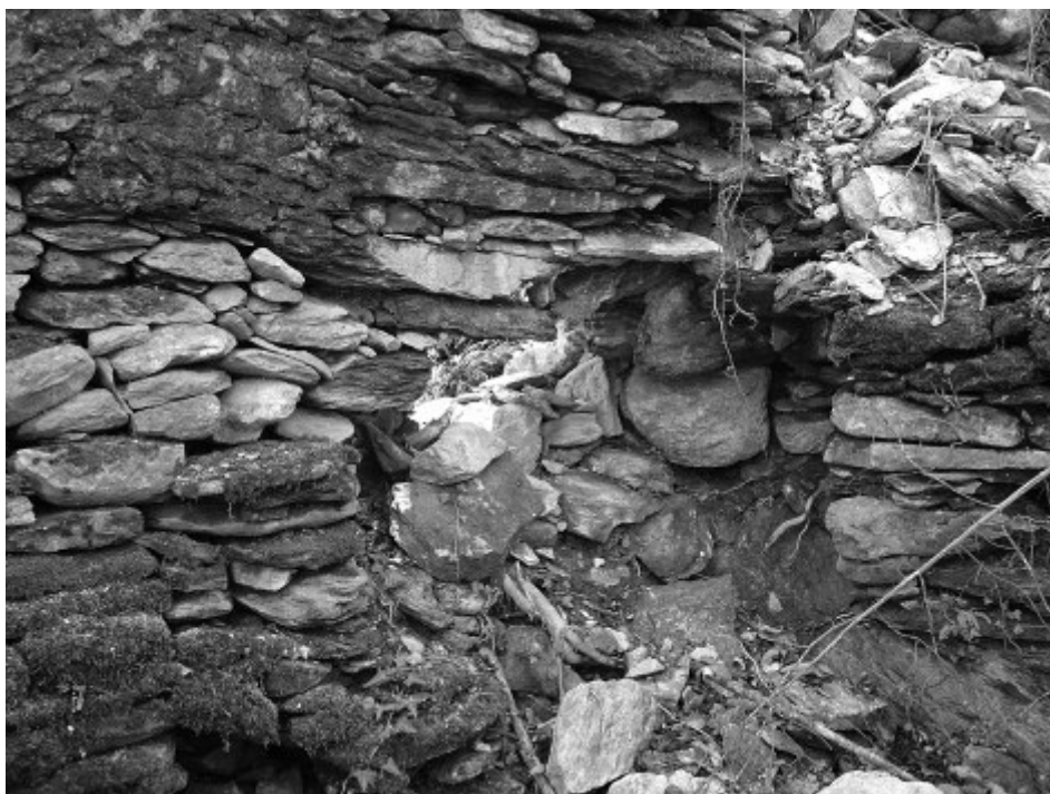
Fig. 40) Dettaglio dell'ingresso dell'acqua.
