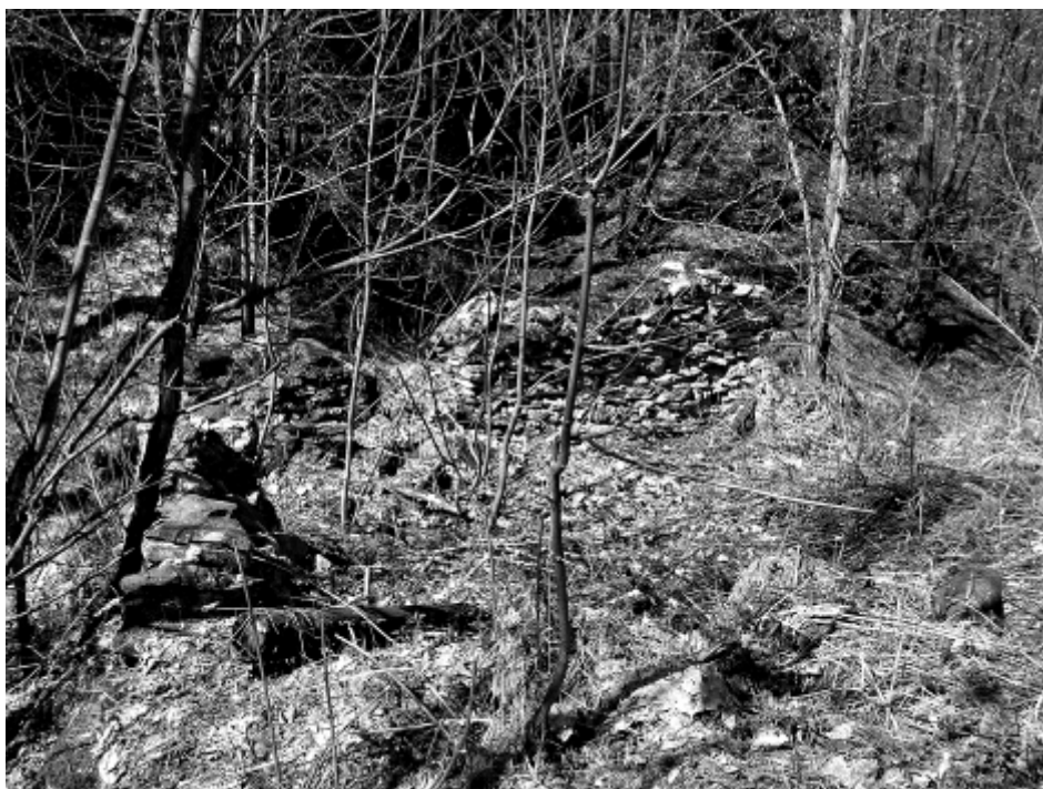
Fig. 56) Mulini di Jouvenceaux, ruderi del mulino mediano. Dalle dimensioni e dalle caratteristiche della muratura, malgrado il degrado, possiamo desumere si trattasse di un opificio a ruota orizzontale.
